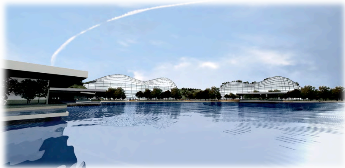
Figura 5: vista dai laboratori verso i biomi
