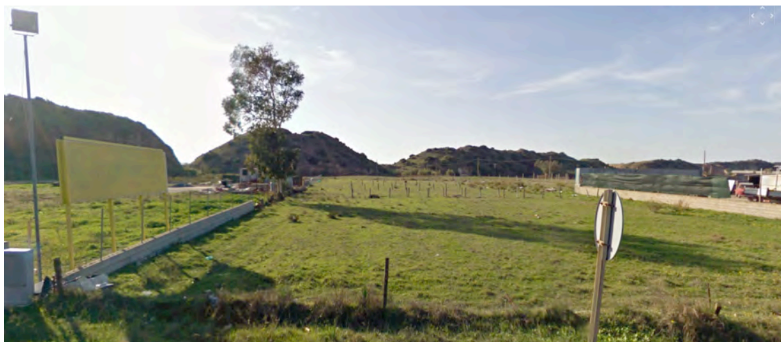
vista attuale del ramo NW della discarica dalla S.S. 126
