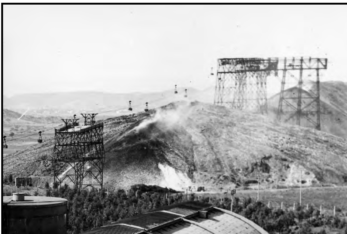
Foto 5: Vista della discarica e della teleferica con cui gli sterili venivano depositati
