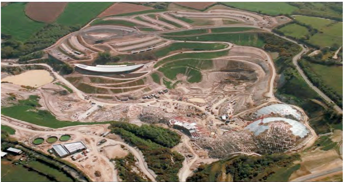
La fase di costruzione dell'Edenproject
