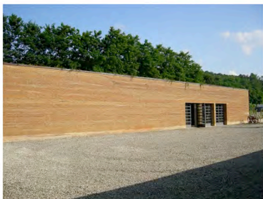
immagine 5 esempi di costruzioni in pisé (Martin Rauch)
