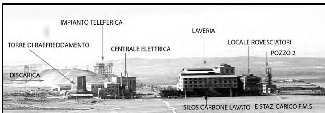
Foto 6: impianti dell'area mineraria
