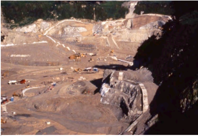
Il sito dopo i lavori di movimento terra
